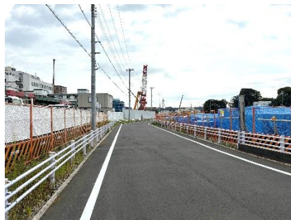
区画整理事業の仮設道路
