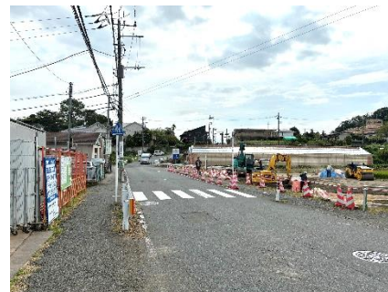
南口アクセス道路工事
